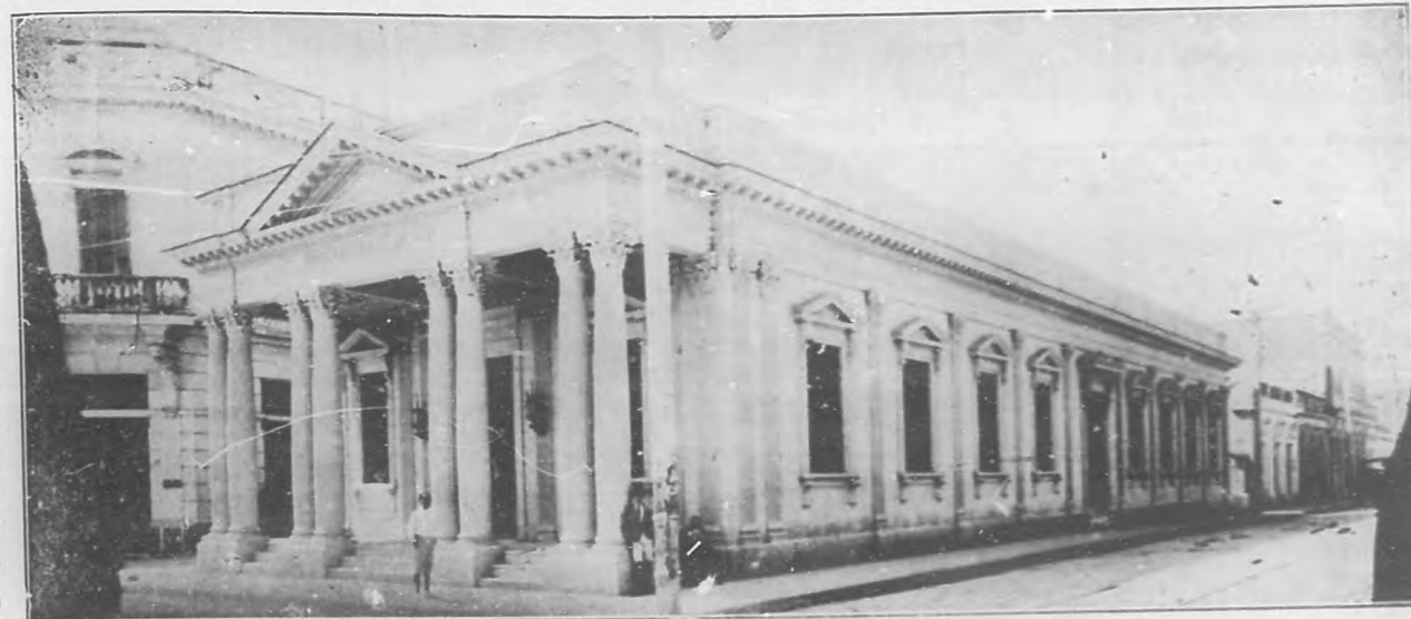
EL BANCO NACIONAL EN CIENFUEGOS.—Vista exterior del edificio que ocupa la poderosa institución bancaria
