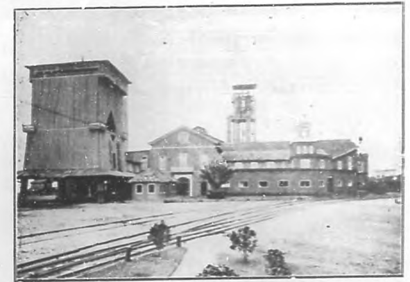
Vista exterior de la casa de maquinaria del Central "Portugalete".
