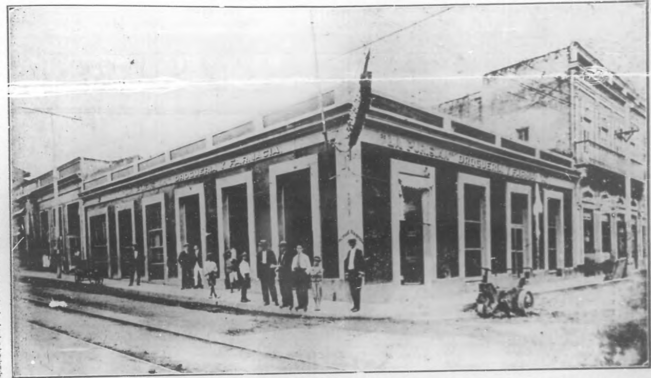
Vista exterior del hermoso edificio de planta baja que ocupa la Droguería y Farmacia "La Purísima", uno de los establecimientos más importantes de Cienfuegos.
