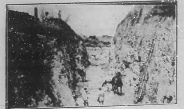
Excavación por donde circulará el ferrocarril a las Minas, construido por el señor Juan Garriga.
