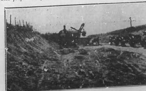
Excavación del ferrocarril eléctrico, en las obras dirigidas por el señor Juan Garriga.
